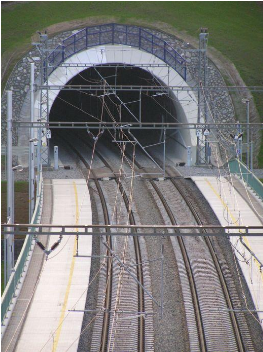
Portál Krasíkovského tunelu u zastávky Tatenice
