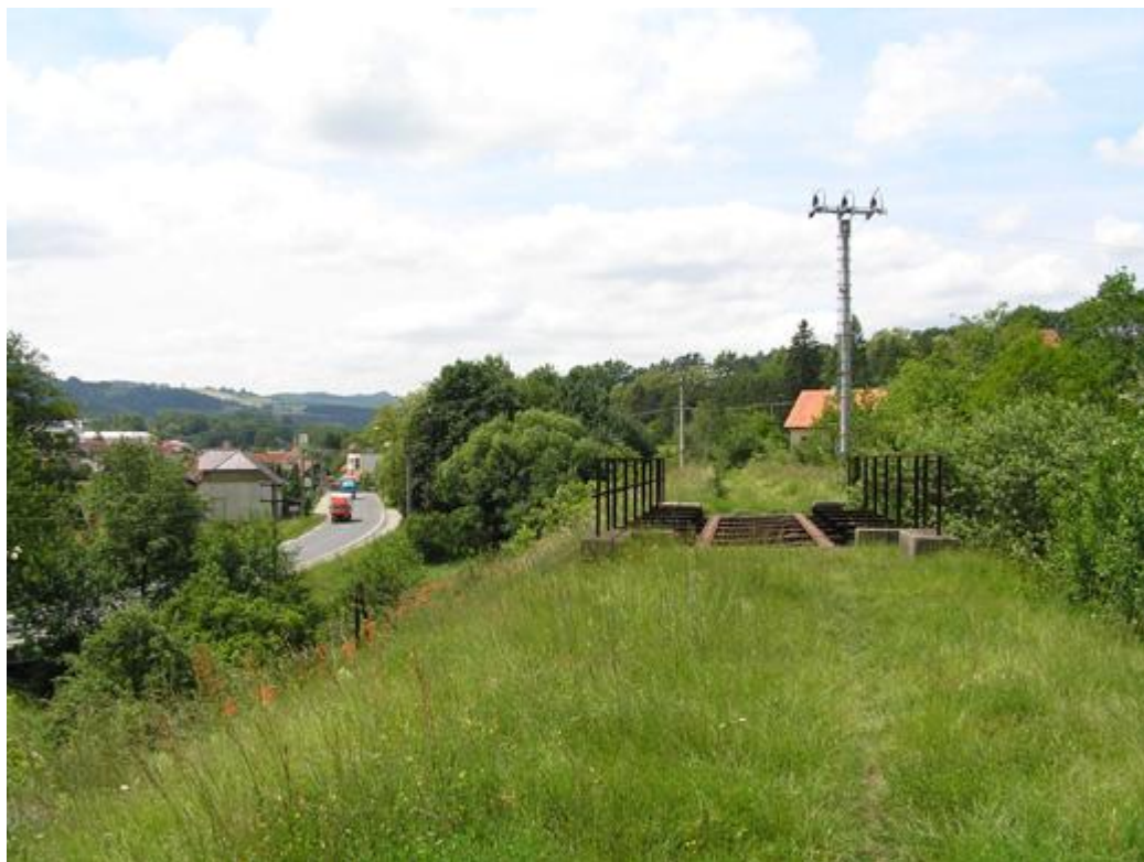
Železniční most na okraji Vizovic
